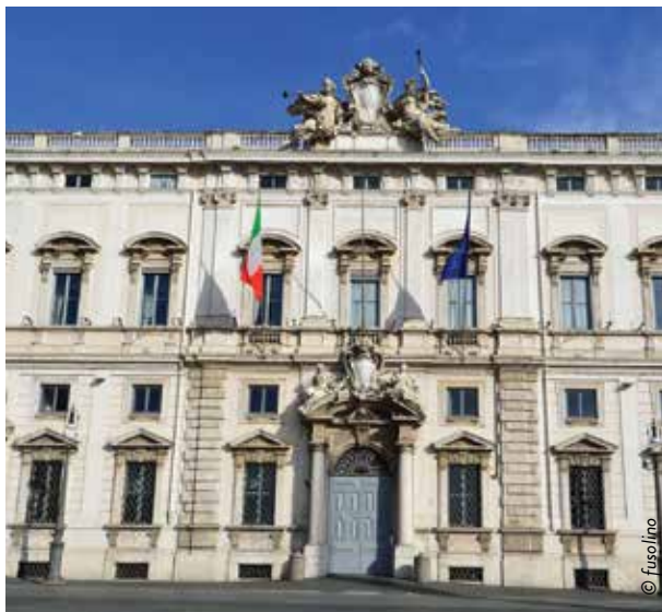
Sede della Corte Costituzionale (Roma)
