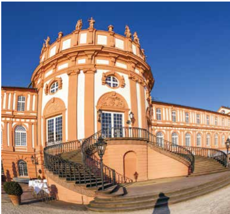
Castello di Biebrich nel distretto di Wiesbaden
