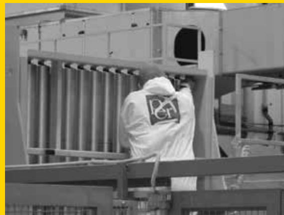
Un operatore di per durante un intervento di risanamento post danno
